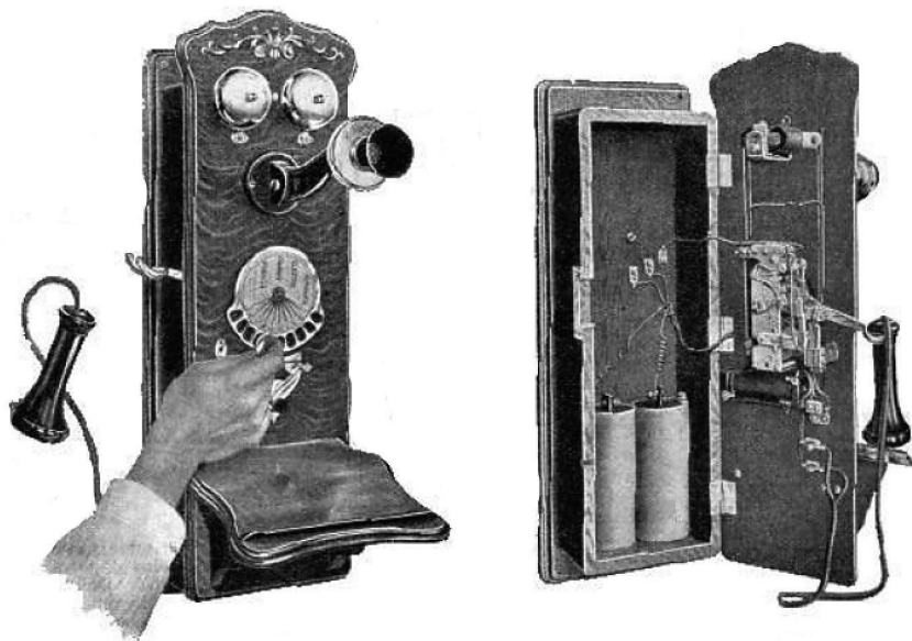
Bild 8: Teilnehmerapparat der Berliner Anlage als Wandapparat (rechts Innenansicht)
