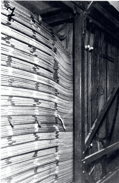
Bild 74: V-Schrank des Hauptamtes für 20 000 Anschlüsse von der Rückseite gesehen
