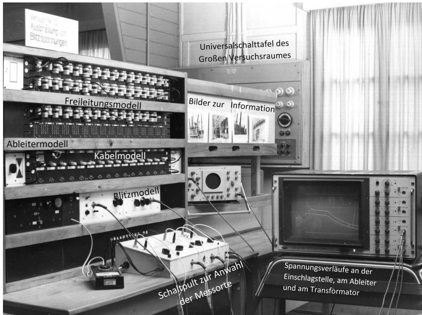
Bild 44: Versuchsstand 10 „Ausbreitung von Blitzspannungen“ (bestehend aus Bausteinen des TNA) für das Laborpraktikum zur Vorlesung „Netzbetrieb“ /Foto: Film- und Bildstelle der TU Dresden/
