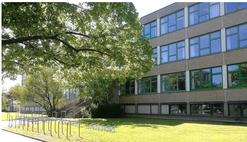
Bild 28: Institut für Elektrische Energieversorgung im Erdgeschoss des Seminargebäudes SE1, Zellescher Weg 22 /Foto: H. Bauer/
