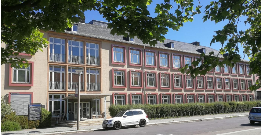
Bild 29: Institut für Elektrische Energieversorgung und Hochspannungstechnik im Erdgeschoss des Toeplerbau, Mommsenstraße. Dynamisches Netzmodell im Untergeschoss /Foto: H. Bauer/
