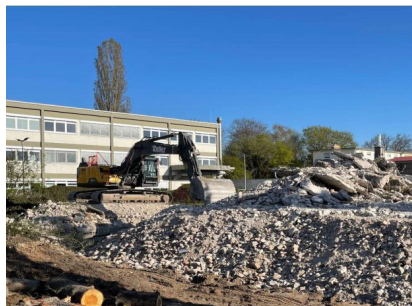
Baufeld auf dem Gelände des Prüf- und Zertifizierungsinstituts in Offenbach (Quelle: Präsentation zur 173. Delegiertenversammlung)
