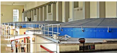
Bild 3: Im Maschinenhaus die Generatoren-Hauben
