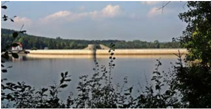
Bild 4: Blick zur Staumauer
