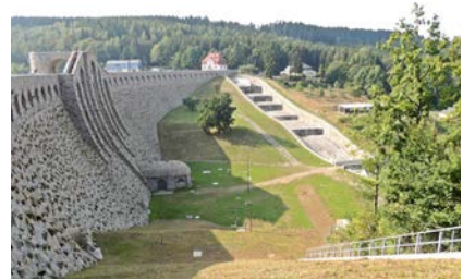
Bild 2: Die Staumauer und die Überlauf-Kaskade
