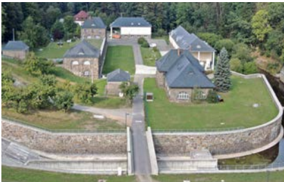
Bild 1: Die technischen Gebäude der Talsperre
