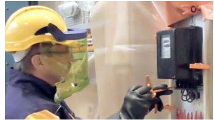
Auswechseln eines Zählers
